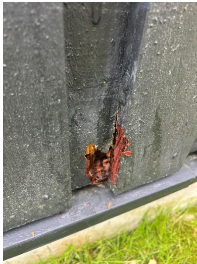
Torrspickor, rötskador och påväxt på gavelfasaden. Bytesbehov.
