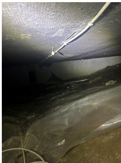
Krypgrunden har lite organiskt byggspill på marken och plasten täcker inte hela ytan, något mindre avvikande lukt i utrymmet. Fuktigt i marken vid besiktningstillfället. Trossbotten skivorna hänger något och lokalt kan man se isolering sticka ner. Kontakta behörig fackman för konsultation angående ev åtgärder.
