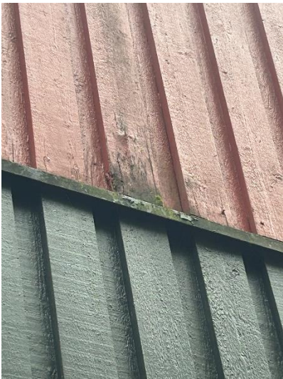
Torrspickor, rötskador och påväxt på gavelfasaden. Bytesbehov.
