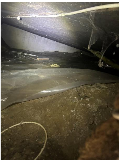
Krypgrunden har lite organiskt byggspill på marken och plasten täcker inte hela ytan, något mindre avvikande lukt i utrymmet. Fuktigt i marken vid besiktningstillfället. Trossbotten skivorna hänger något och lokalt kan man se isolering sticka ner. Kontakta behörig fackman för konsultation angående ev åtgärder.
