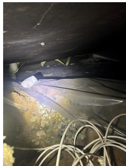
Krypgrunden har lite organiskt byggspill på marken och plasten täcker inte hela ytan, något mindre avvikande lukt i utrymmet. Fuktigt i marken vid besiktningstillfället. Trossbotten skivorna hänger något och lokalt kan man se isolering sticka ner. Kontakta behörig fackman för konsultation angående ev åtgärder.
